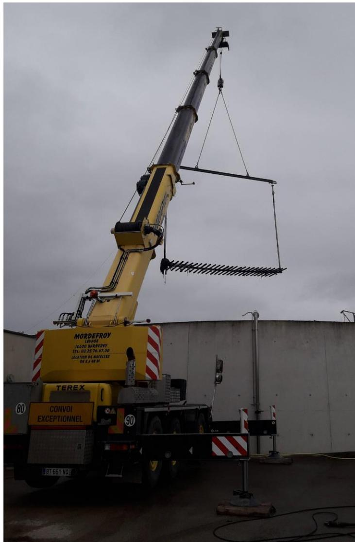
*Figure 1 : Renouvellement des membranes des rampes d'aération*
